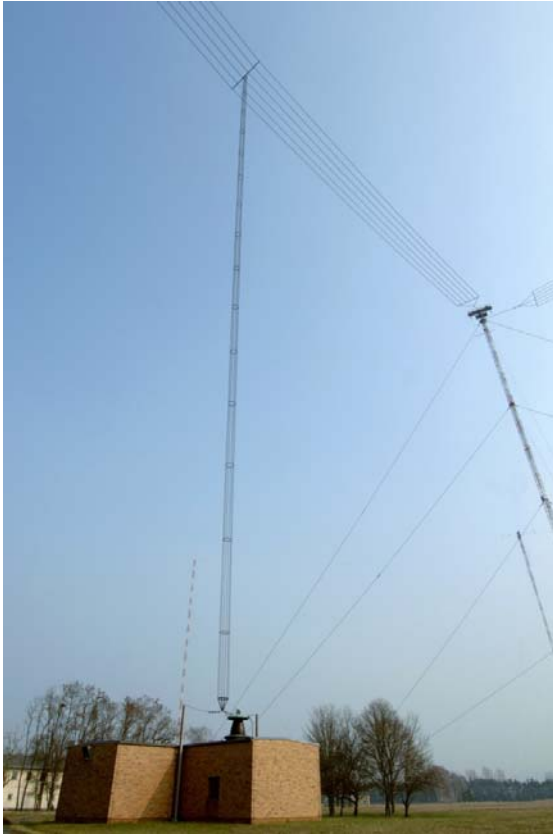
Bild 4 Antennenhaus mit darüber hängender Antenne des Langwellensenders DCF77.
